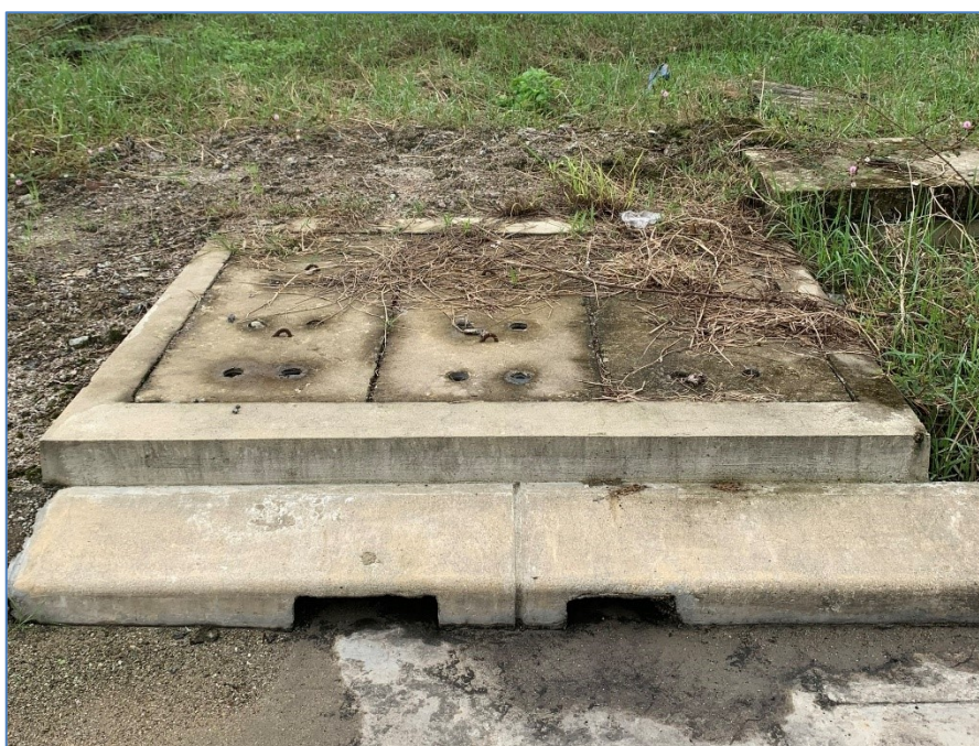
Hình 3.2. Hố ga và mương thu gom, thoát nước mưa của Nhà máy
