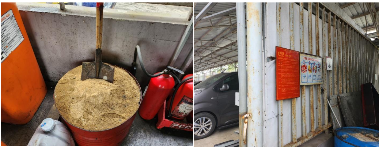
Hình 3.15. Thiết bị PCCC tại kho CTNH
