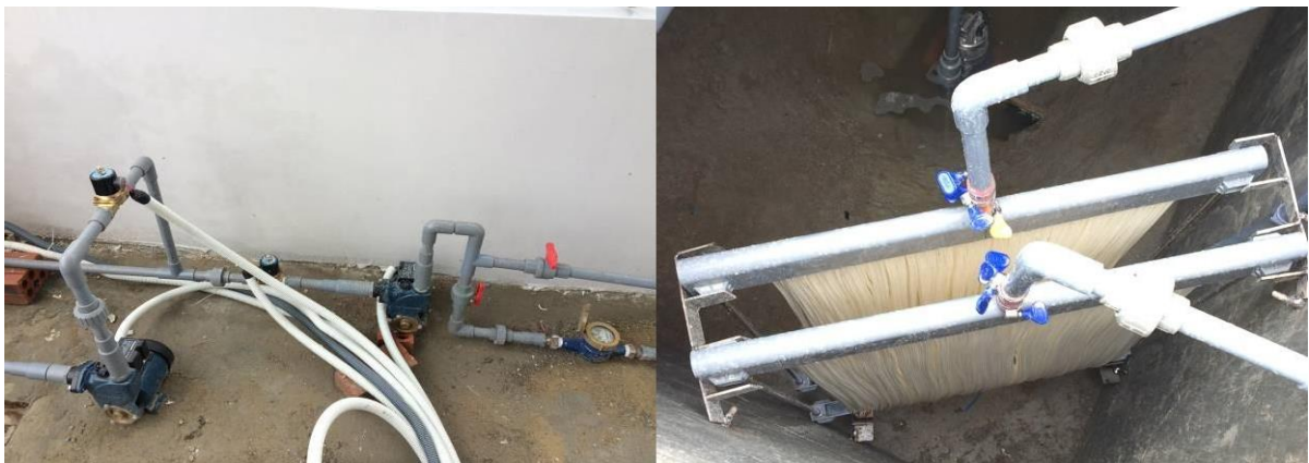
Hình 3.6. Bơm hút - rửa màng MBR, đồng hồ lưu lượng và màng MBR
